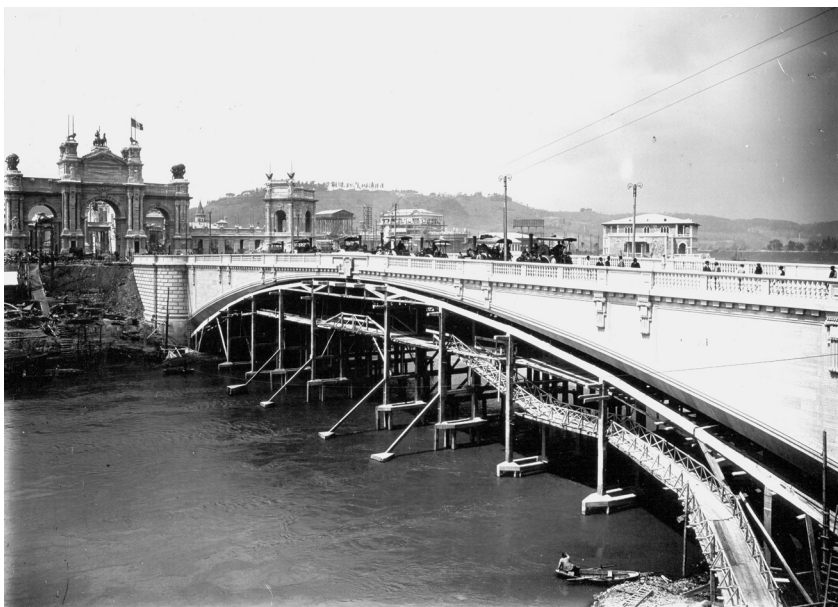
Fig. 6 - L'esecuzione della prova di carico con i rulli, a metà aprile del 1911. La centina in cemento armato è ancora in opera (ASPorcheddu)
